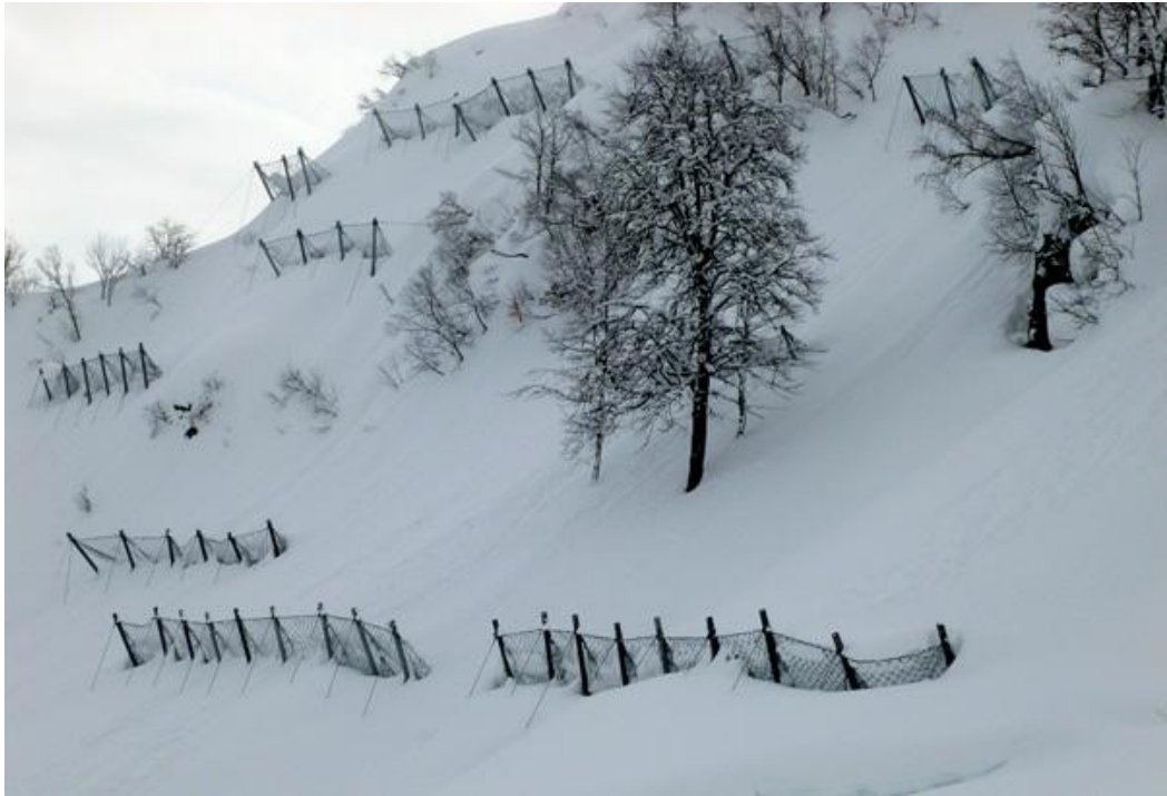
ნახ. 28. ზვავის შემაკავებელი ალუმინის ბადე.
