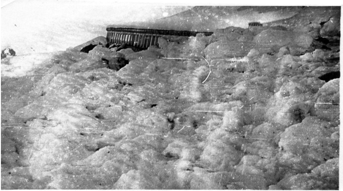
ნახ. 27. ზვავსაწინააღმდეგო გალერეა საქართველოს სამხედრო გზაზე.
