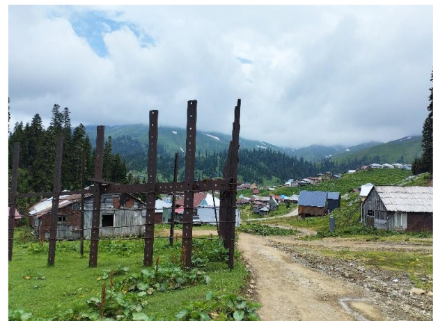
ნახ. 10. ზეგვშემკავებელი კონსტრუქცია. კურორტი ბახმარო.
