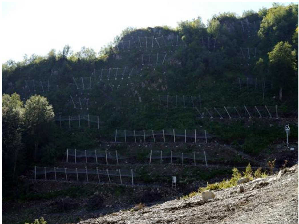
ნახ. 29. ზვავის შემაკავებელი ნეილონის ბადე.
